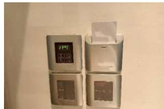
ระบบ KEY CARD ควบคุมระบบไฟฟ้าในห้องพัก
