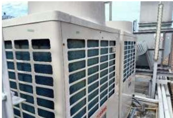
ระบบเครื่องปรับอากาศแบบ VRF
