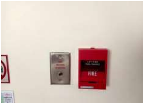
Telephone Jack และ Manual Station
